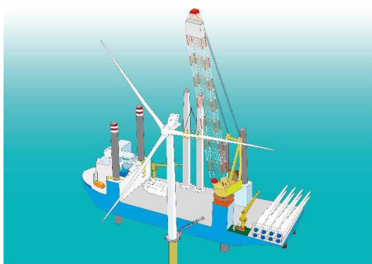
専用船利用の洋上風力発電設備の建設工事
